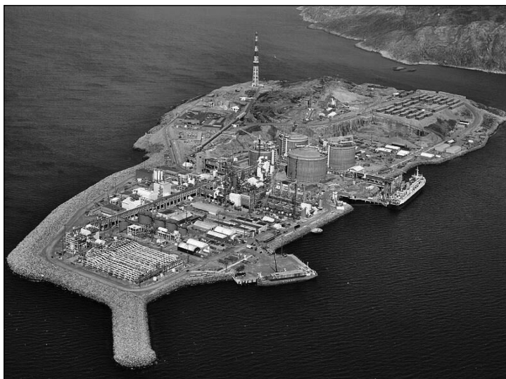
Рис. 14. Завод по переработке и сжижению газа месторождения Snohvit на острове Melkoya
